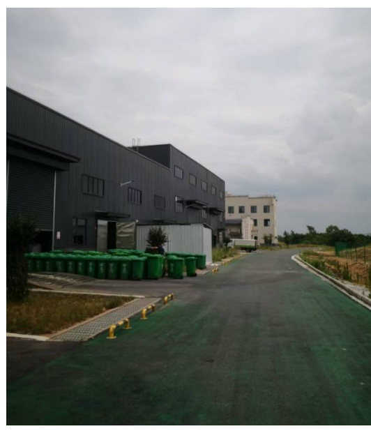
厂区地面硬化
