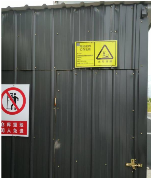
危险废物暂存间
