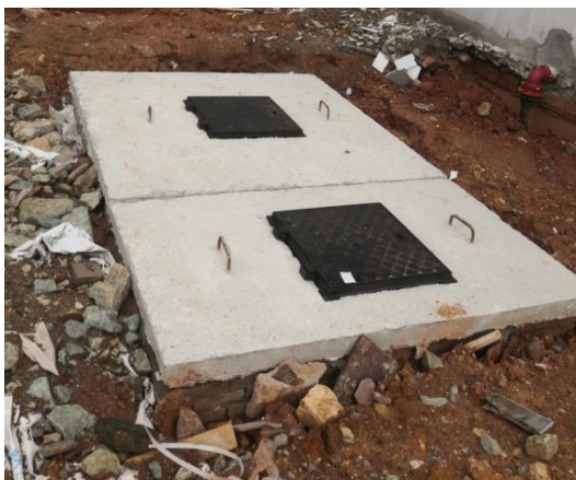
隔油池+化粪池
