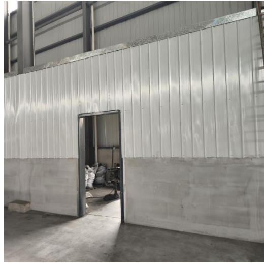
一般固废暂存间
