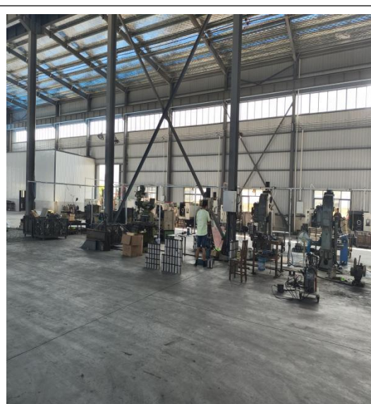
车间地面硬化
