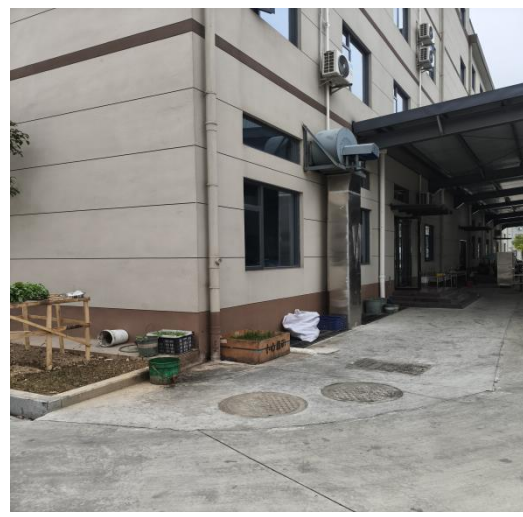
生活污水排放口
